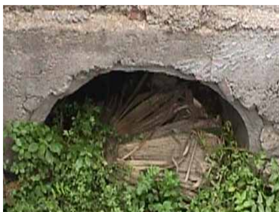
Figura 2.6.2.4 – Rio Fine: particolare della tubazione di imbocco.
