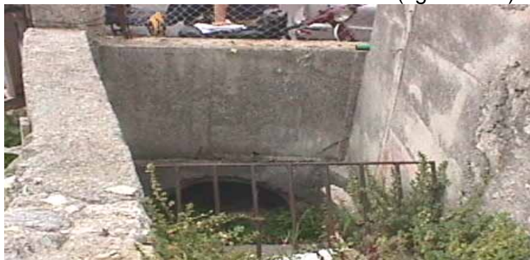
Figura 2.6.2.3 – Rio Fine: sezione di imbocco della copertura.
