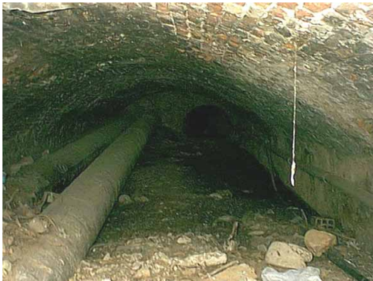
Figura 3.4.1.1.7 – Copertura sotto l'ingresso del cimitero. In lontananza si può scorgere il tubo che raccoglie le acque del compluvio.
