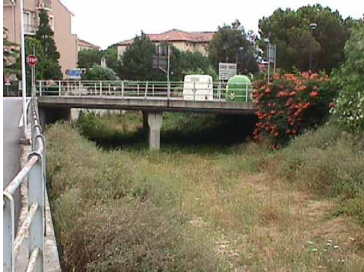
Foto 2.6.1.6: Torrente Bottassano – Ponte di Via IV Novembre - vista da monte
