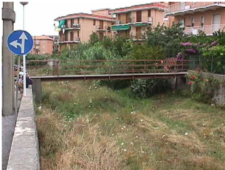
Foto 2.6.1.4: Torrente Bottassano – Passerella pedonale privata – vista da monte
