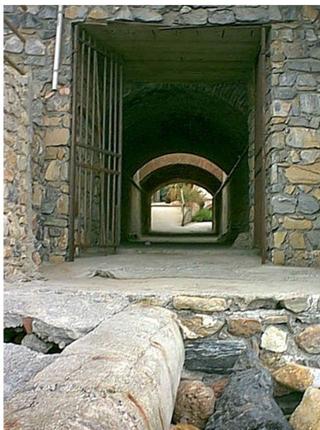
Figura 3.4.1.1.9 – Sottopasso visto dalla scogliera a ridosso del mare.
